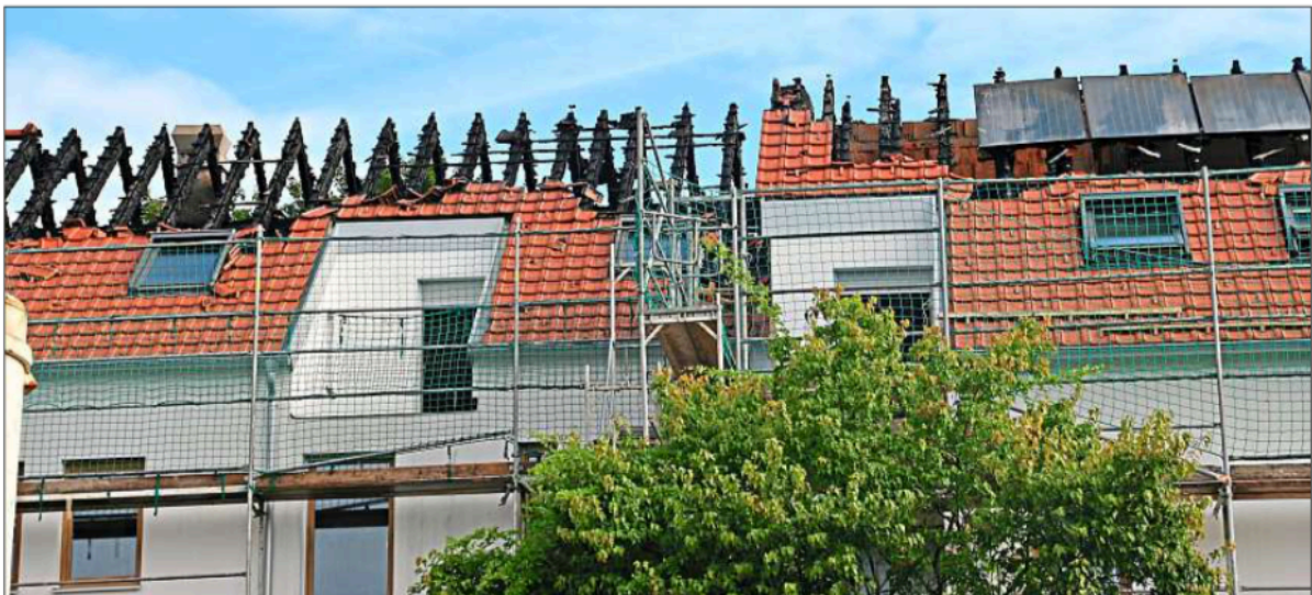
Der Dachstuhl des fast fertiggestellten Sozialwohnungsbaus in Rittsteig brannte in der Nacht zum Donnerstag aus.
