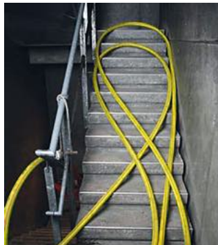
Abb. 25 Verlegen der Schlauchreserve im Innenbereich
