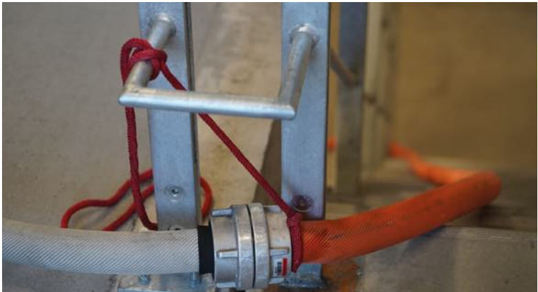
Abb. 24 Sichern der Schlauchleitung
